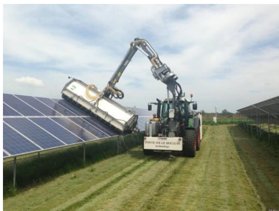
Рис. 2. Очистка панелей солнечных батарей
